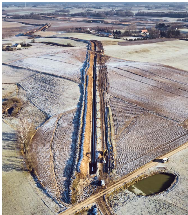
W Polsce buduje się tysiące kilometrów gazociągów / fot. Gaz-System
