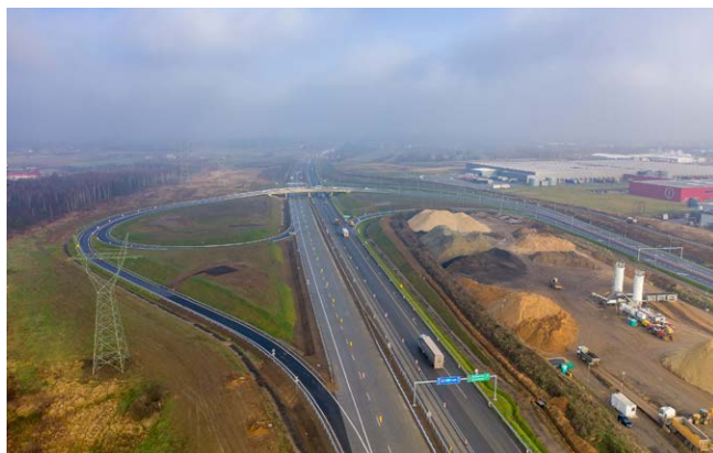
Autostrada A1 na przebudowywanym obecnie odcinku Kamieńsk-Radomsko / fot. GDDKiA
