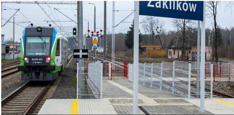
Zmodernizowany peron w Zaklikowie / fot. PKP PLK
